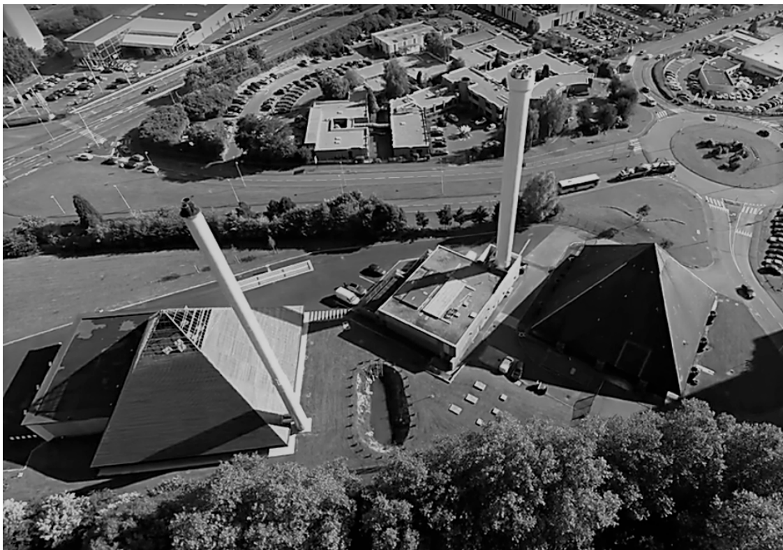
Figure 1 : chaufferie urbaine de Mons-en-Barœul
