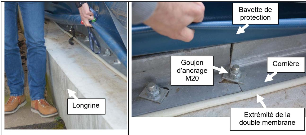
Le bureau d'études structure a déterminé les composantes de la force maximale  $\vec{F}$  appliquée sur un goujon d'ancrage au point A (DRS3) :
