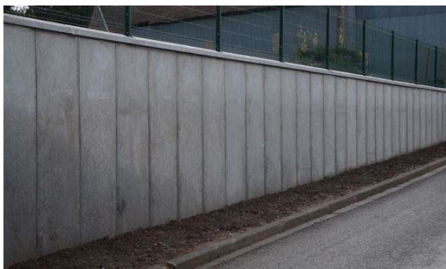
Photo d'un mur de soutènement sur voirie.
